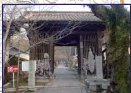
④今高野山総門(仁王門) 「今高野山」の総門として室町時代に建立された。屋根や仁王像の囲い等は後世の補修だが、建立当初の姿を今もとどめている。
