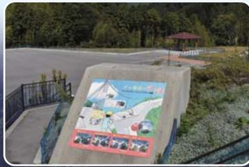
コンクリートを運搬するためのケーブルクレーンを固定する基礎を現地に保存。本体ダムでは、約31万㎡、回数にして56,000回コンクリートを運搬しました。
