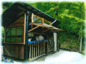
ピザ窯、小屋の作成 (令和4年3月)
